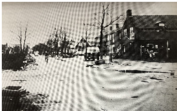
Aanleg riolering Terheijlsterweg rechts groenteboer Bouwes ca 1974
